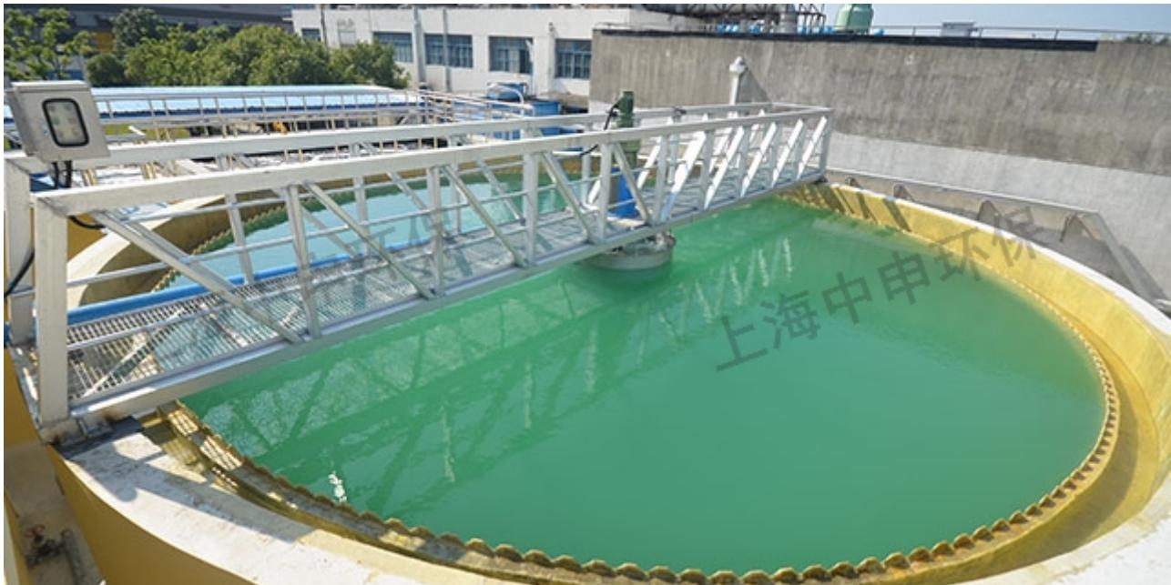
桁车式刮泥机/行车式刮泥机/高效沉淀池刮泥机/二沉池刮泥机/往复式刮泥机/链条式刮泥机，适用于给排水工程中的平流沉淀池。沉淀在池底的污泥被刮至污泥收集池，池面浮渣被撇至污泥收集池。浮渣刮板可根据用户要求设置。当刮片机构不刮地返回时，刮板完全升起。当刮泥机回到刮泥初始位置时，刮板掉落，反复工作。适用于污水处理厂、给水厂和工业生产中的平流式沉淀池或斜管沉淀池，用于去除沉淀在池底的污泥，撇除池表面浮渣。工作原理：潜污泵由主梁两端横梁上的驱动装置驱动，随主梁移动，将沉淀在池底的污泥吸收，通过污泥输送管排至池外排泥沟。
