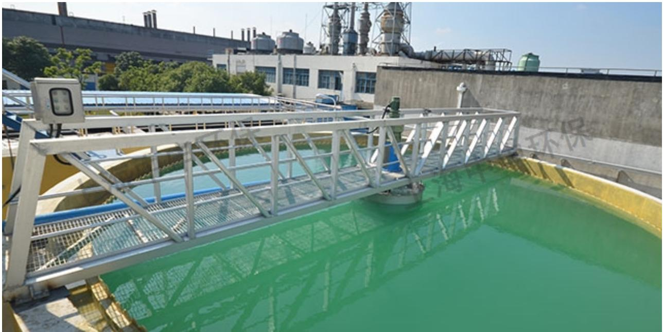
刮泥机整机应包括：电机驱动系统（包括减速机、电机及过载保护系统）；工作桥；中心支柱；配水槽穿孔管和挡水裙板；出水堰；浮渣去除系统（包括冲洗设备）；支架；集泥管；桁架放置及套筒式排泥阀，就地控制箱以及安全和有效运行所需的附件。沉淀池吸泥系统采用周边传动刮泥机。通过内啮合齿轮装置带动中心柱架、吸泥管、撇浮渣等转动，吸泥管将污泥沿池底收集至中心排泥管后，通过池内水压排至池外。为保证回流污泥不小于 6g/L 的浓度要求，应在不同污泥回流比时的浓度进行排泥量控制，并提供所需的排泥量调节装置。双周边传动虹吸刮泥机密封装置及其密封装置的优化。北京刮泥机源头直供厂家
