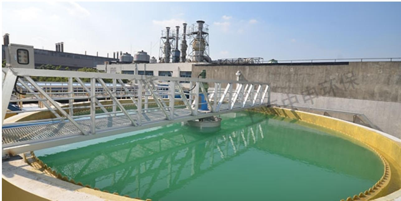
往复式液压刮泥机可手动或自动控制。手动控制通过切换控制面板上的“手动/远程”选择开关至“手动控制位置”，通过“启动”按钮开始手动控制操作。自动控制控制箱控制面板上需有“手动/远程”选择开关至远程控制，可实现自动操作。刮泥机按预先设定的时间控制。当启动信号开始，刮泥机开始运行一个周期。运行周期根据水质情况可调。就地控制箱将从自动控制系统发出和接受如下信号：a.发送信号到控制系统：手动/自动，运行/停止，急停，断电及其它状态信号。
